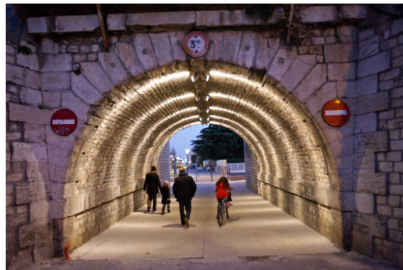
Eclairage indirect de la voûte du tunnel avec des 4040 - Luminy 4 à faisceau elliptique.
